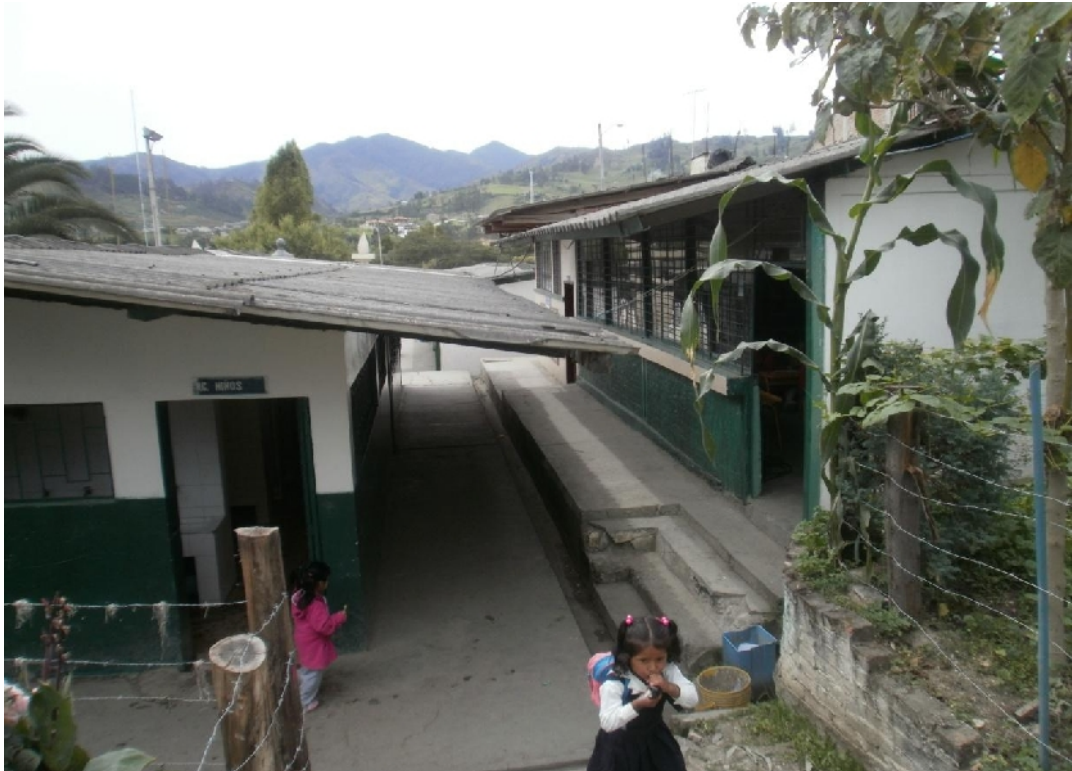
Infraestructura interior. Salones de Clase
