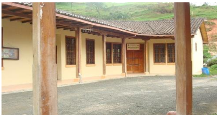
Imagen 119. Biblioteca Municipal Fotografía: Johana Armijos (2010)
