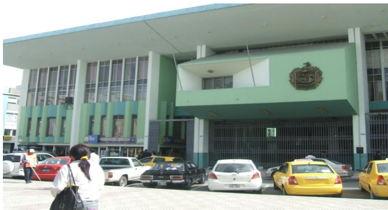
Imagen 5. Ingreso al Municipio de Loja por la calle José A. Eguiguren Fotografía: Juliana Torres. (2010)
