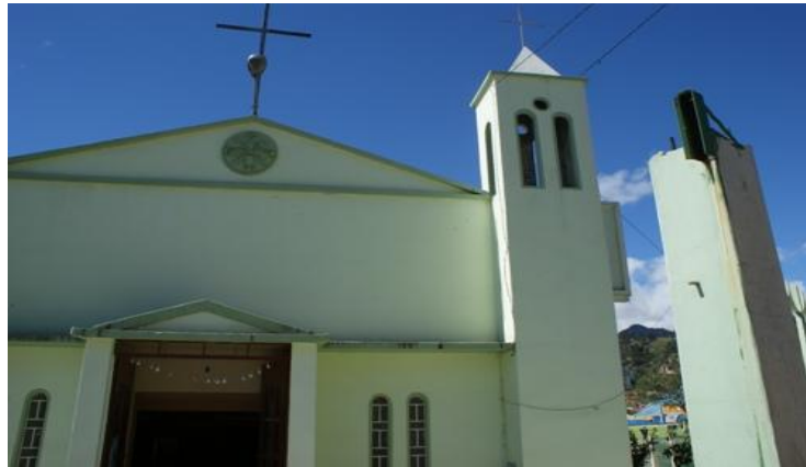
Imagen 58. Iglesia Cristo Rey Fotografía: Juliana Torres. (2010).
