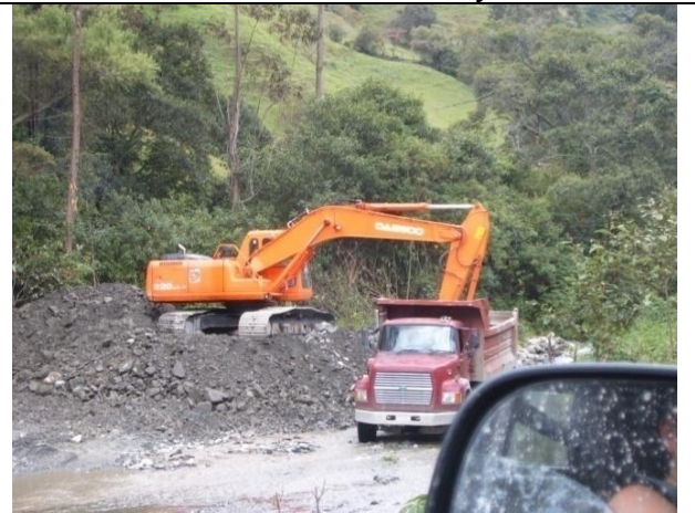
Foto 10. Extracción de material pétreo de los ríos
