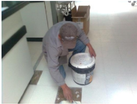
Cambio de baldosas dañadas
