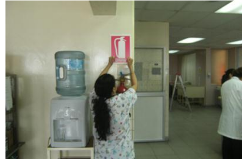
Extintor de incendio (Con señales)
