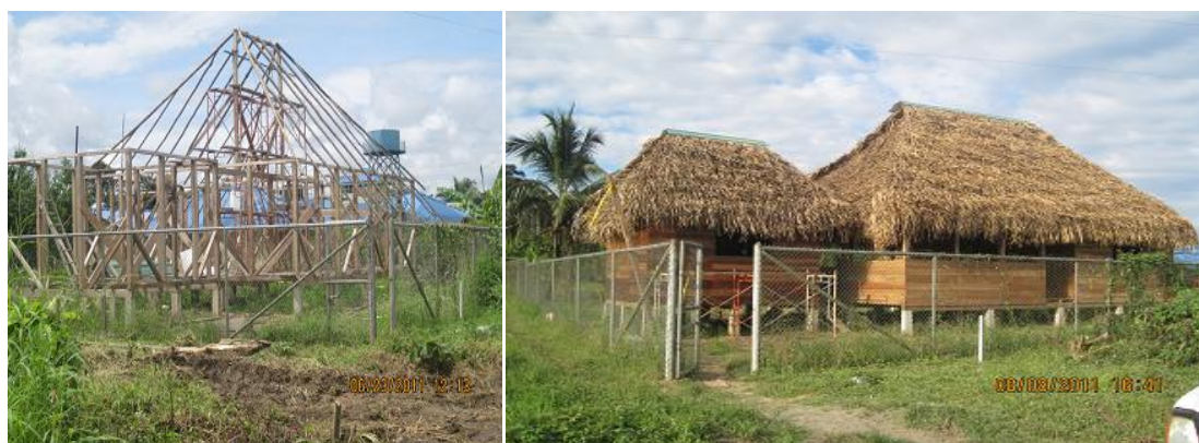
Construcción de la Huarmi Huachana Huasi o Casa del Parto
