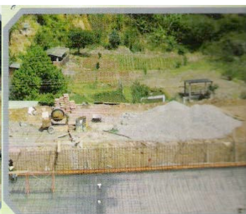
Construcción de la piscina semiolímpica de Olmedo.
