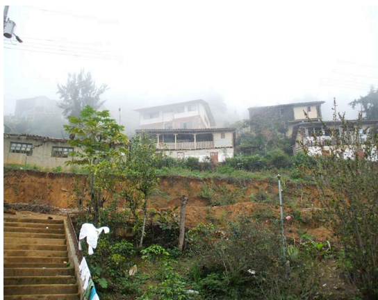
Infraestructura de la parroquia La Tingue, la autora, 2010.
