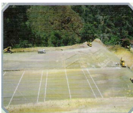
Construcción del estadio de Olmedo.
