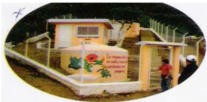
Planta de tratamiento de agua potable del cantón Olmedo, la autora, 2010
