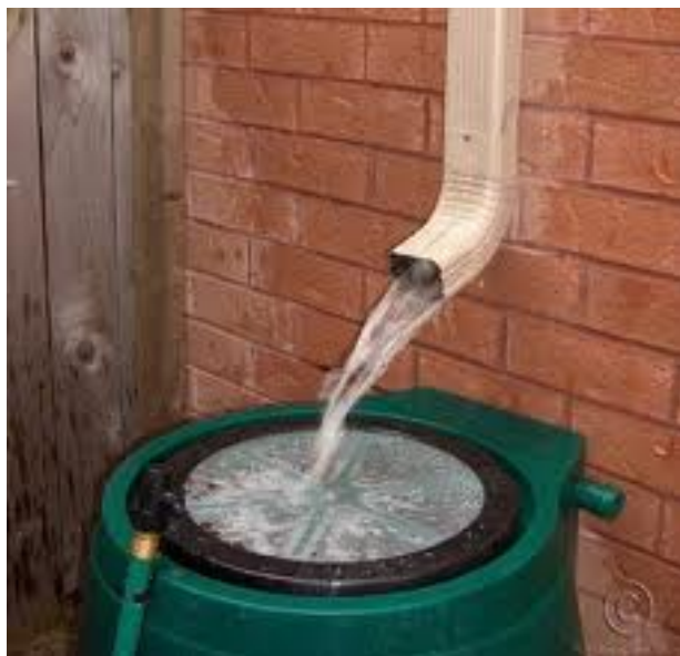
Fig. 5.5 Filtración de primeras aguas [Disponible en: http://www.tuverde.com/tag/tips/page/2/ ]
