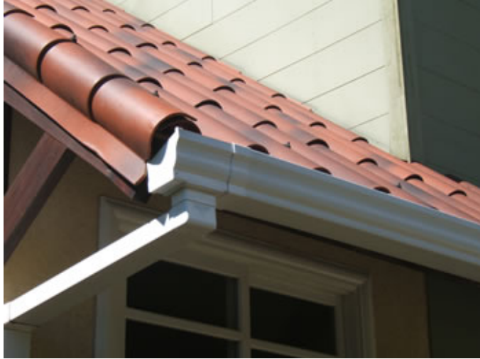
Fig. 5.3 Módulo de recolección y conducción: canaletas [Disponible en: http://www.deguate.com/artman/publish/bienesraices_actualidad/Novedoso_sistema_de_canales_de_pvc_para_la_tempora_9602.shtml ]
