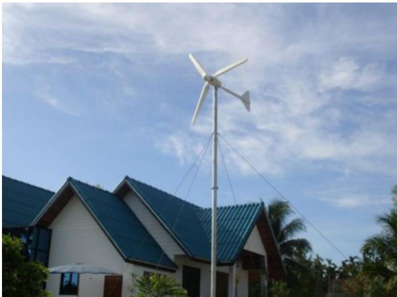
Fig. 3.5 Mini aerogenerador [Disponible en: http://www.construible.es/noticiasDetalle.aspx?id=5718&c=6&idm=10&pat=10 ]
