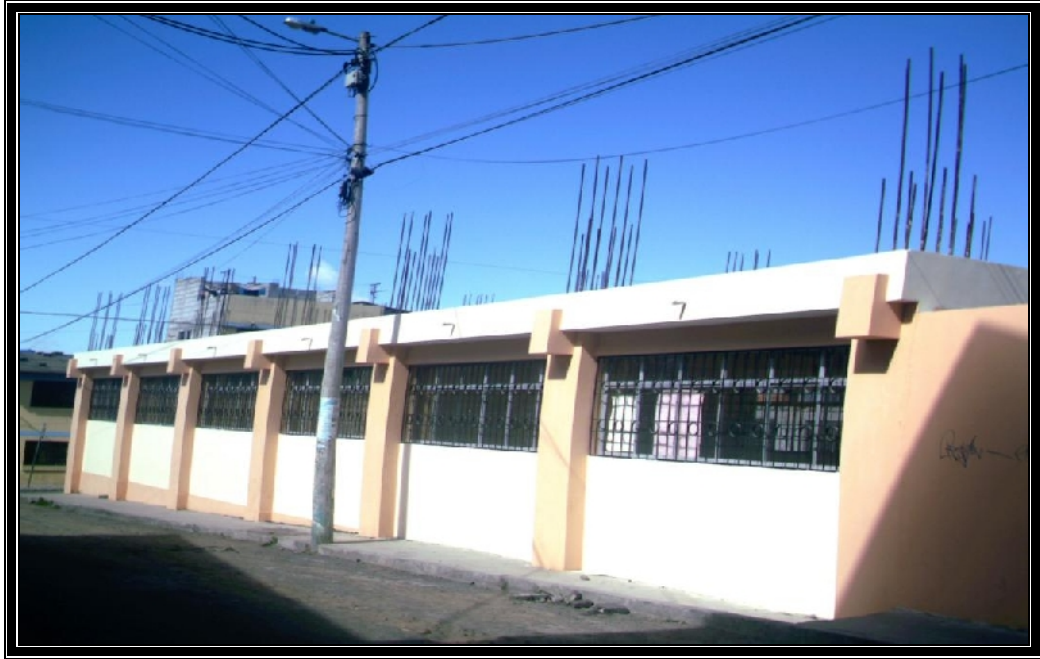
NUEVA CONSTRUCCION PARTE EXTERNA
