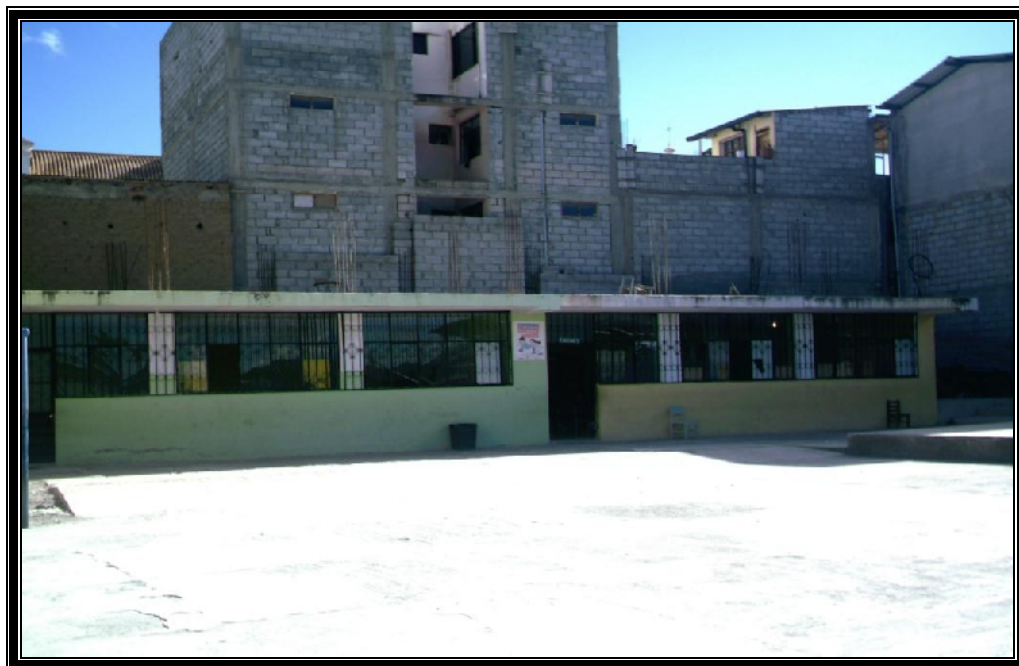
PATIO CENTRAL. AULAS EN CONSTRUCCION
