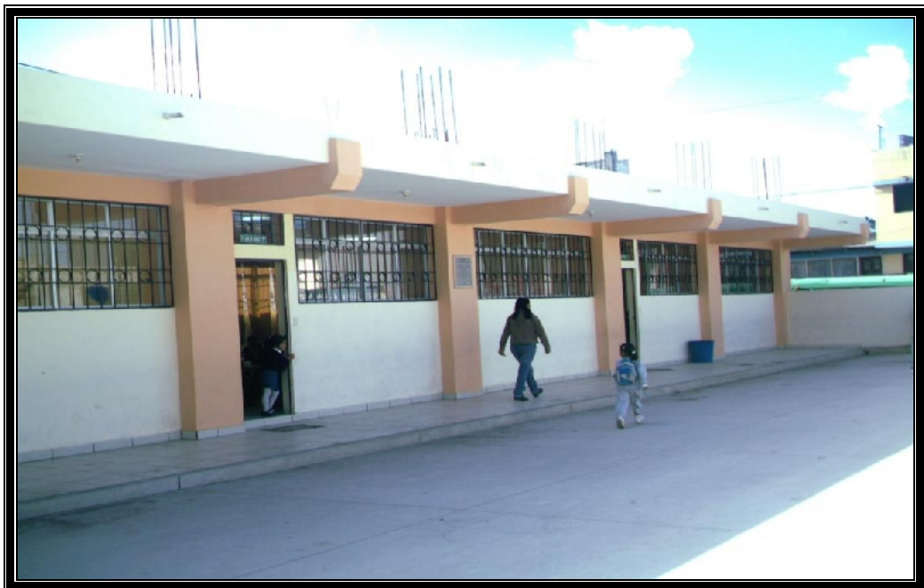
NUEVA CONSTRUCCION PARTE INTERNA
