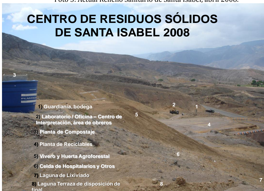
Foto 5: Actual Relleno Sanitario de Santa Isabel, abril 2008.
