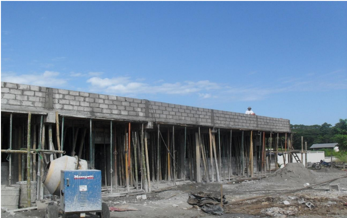
BLOQUES DE AULAS EN CONSTRUCCION
