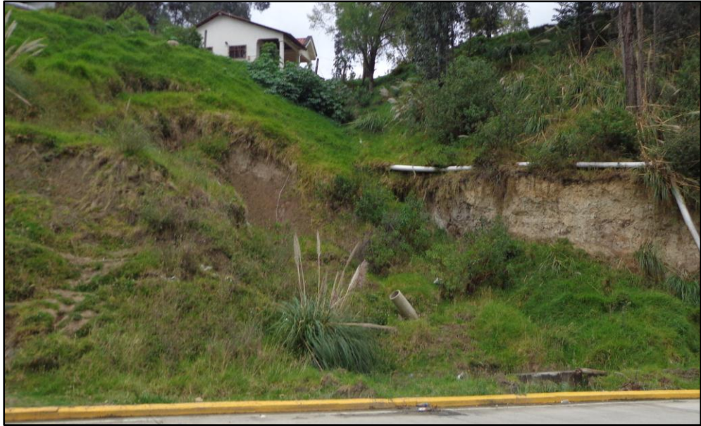
Fotografía VI.1.- Talud 1 de la zona de estudio. Fuente: El autor.
