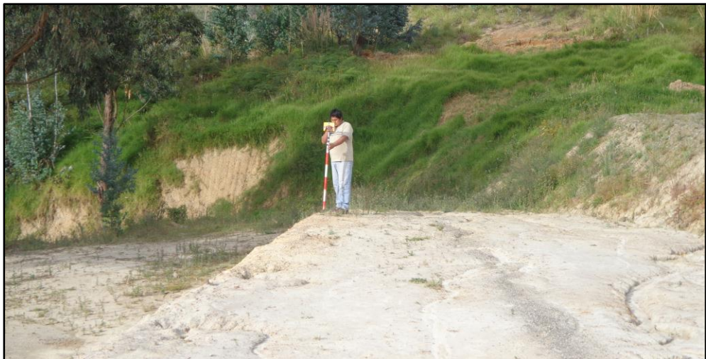
Fotografía VI.2.- Talud 2 de la zona de estudio. Fuente: El autor.
