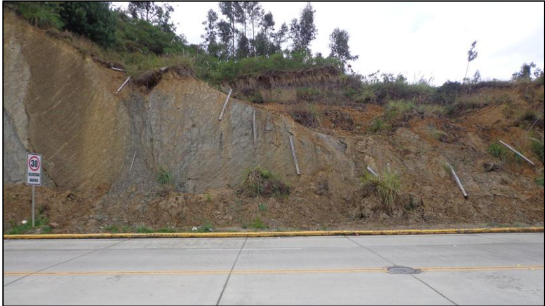
Fotografía VI.5.- Talud 5 de la zona de estudio. Fuente: El autor.
