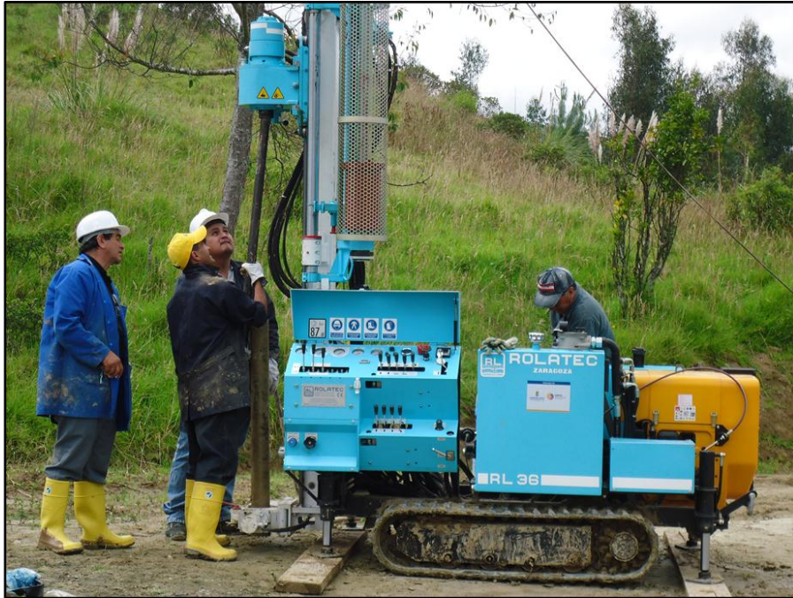
Fotografía VI.7.- Sondeo mecánico en la zona de estudio. Fuente: El autor.
