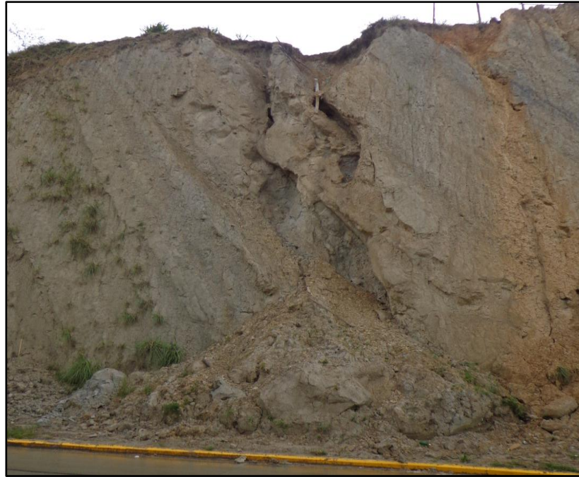
Fotografía VI.3.- Talud 3 de la zona de estudio. Fuente: El autor.
