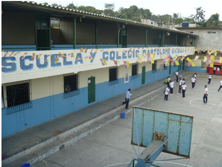
Instalaciones del colegio "Bartolomé Garelli"
