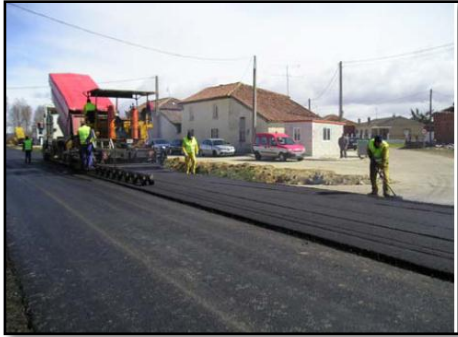
Figura 14 Extendido de asfalto.
