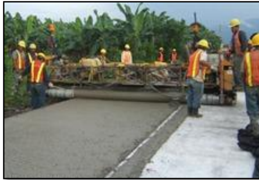
Figura 13 Colocación de hormigón.
