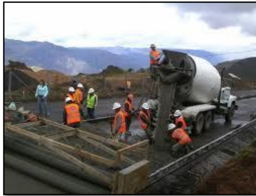
Figura 26 Descarga de hormigón.
