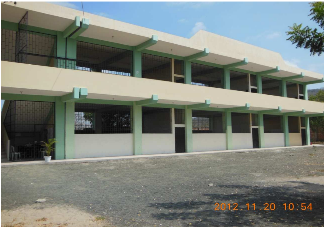
AULAS DEL COLEGIO 12 DE MARZO RECIENTEMENTE CONSTRUIDAS
