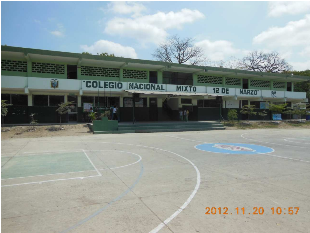
INFRAESTRUCTURA DEL COLEGIO 12 DE MARZO
