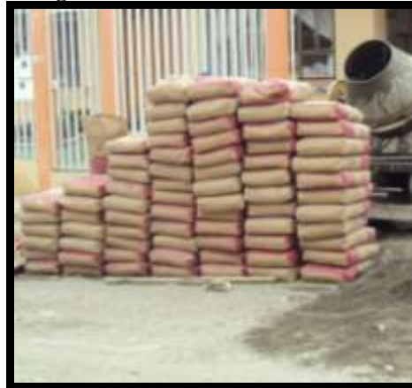
Figura 3. Almacenamiento del Cemento
