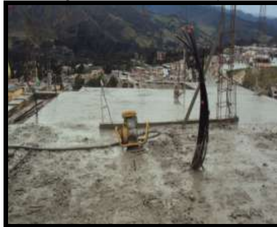
Figura 4. Colocación del Hormigón
