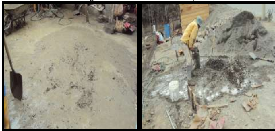
Figura 9. Toma de muestras de Hormigón Fresco
