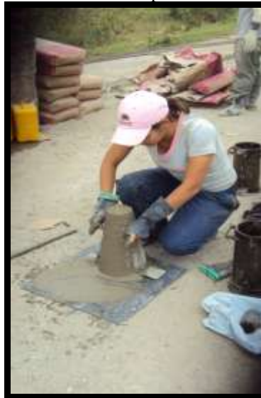
Figura 5. Realización de la prueba del Asentamiento
