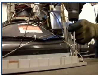
Fig. V.5 Desmontaje de carcasa
