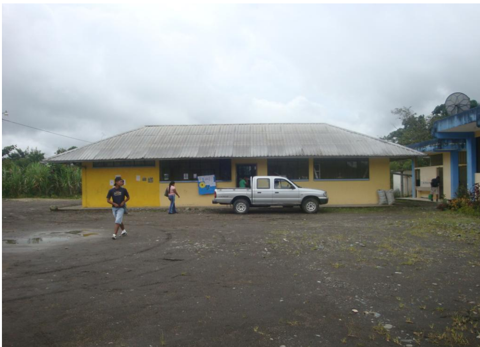
Vista de la llegada y de las oficinas de dirección y parte del lateral izquierdo.
