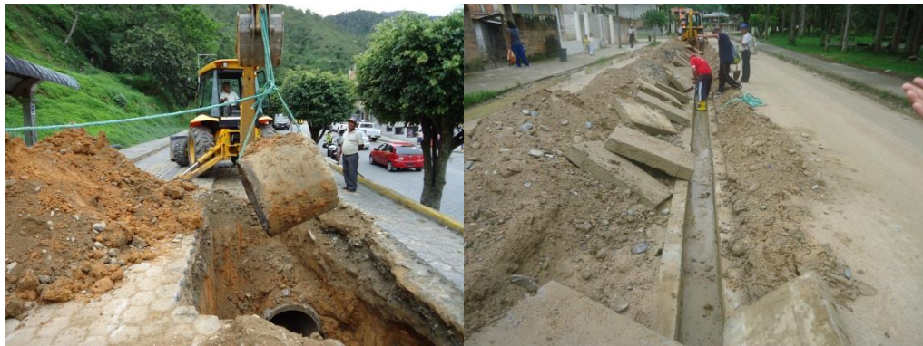
Imagen 3. Servicio de Alcantarillado
