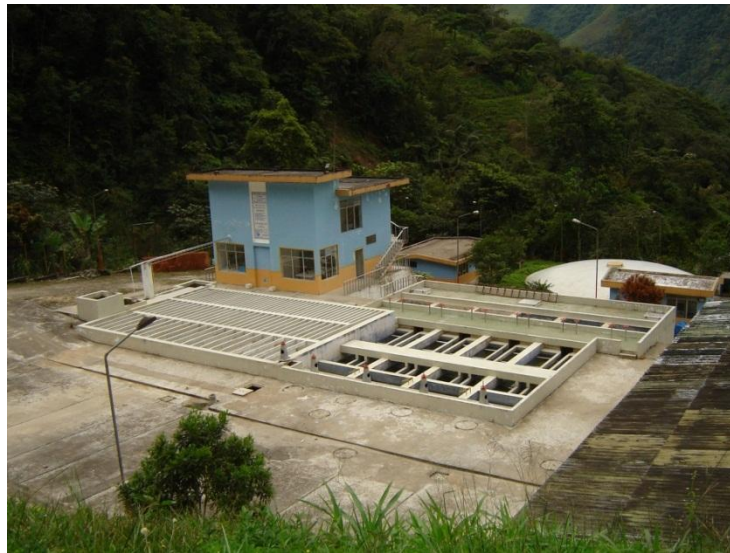
Imagen 2. Planta de Tratamiento de Agua Potable La Albernia
