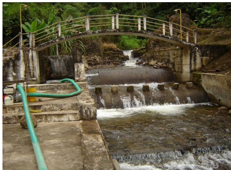
Imagen 1. Estructura de la Captación de Agua
