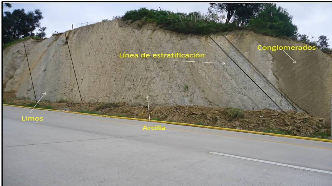
Foto 4.- Arcillas con estratificación e intercalación de micro conglomerado y limo.
