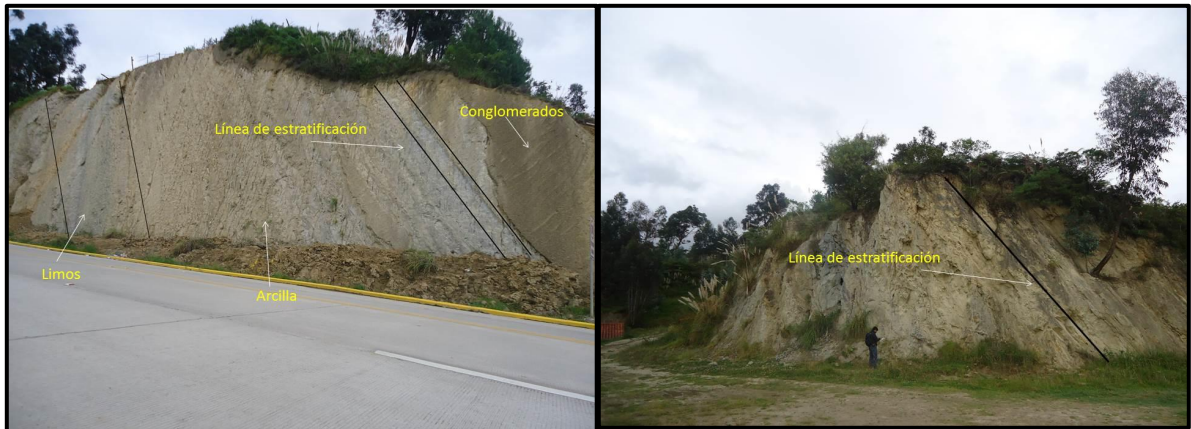
Foto 6.- Estratificación de capas de Arcilla y Limo.
