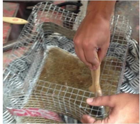
**Fig. 27.** Aplicación de la mezcla sobre la fibra. Fotografía de los autores.
