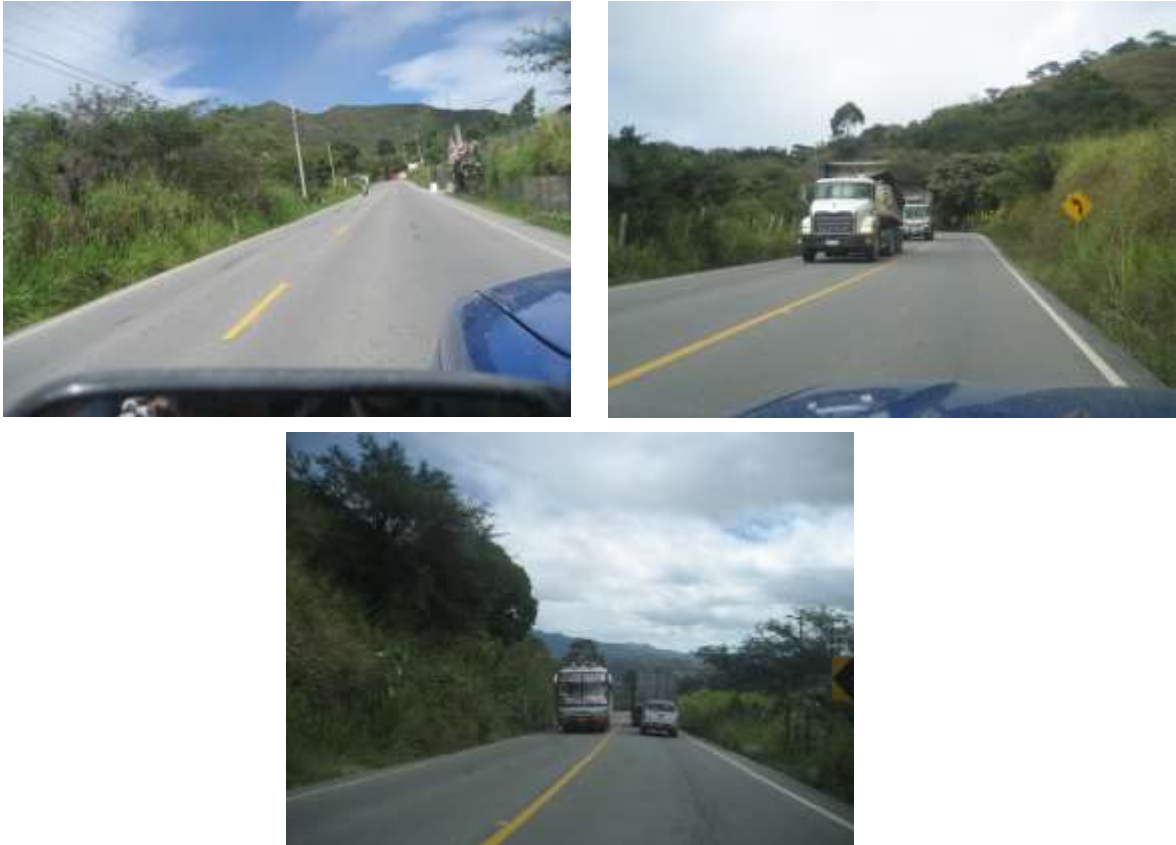
Imagen 3.1 Inspección visual del tramo en estudio
