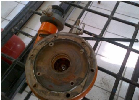
Figura 3.16. Limpieza y remoción del empaque de la cámara del rodete. Fotografía de autores.
