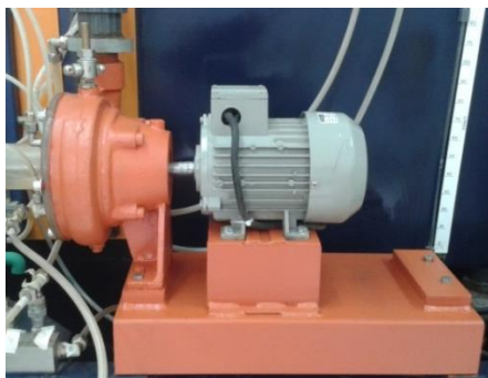
Fig. 31. Instalación del nuevo motor en el banco de pruebas. [Fotografía de autores]
