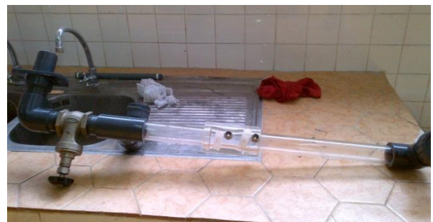
Fig. 22 Tuberías luego del proceso de limpieza. [Fotografía de autores]
