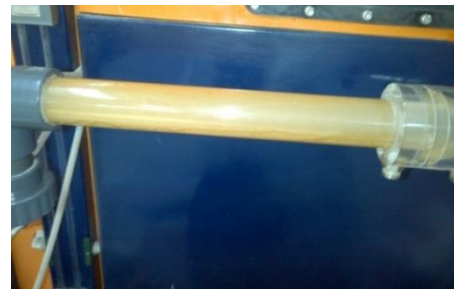
Fig. 14. Vista frontal de la tubería durante la inspección inicial. [Fotografía de autores]
