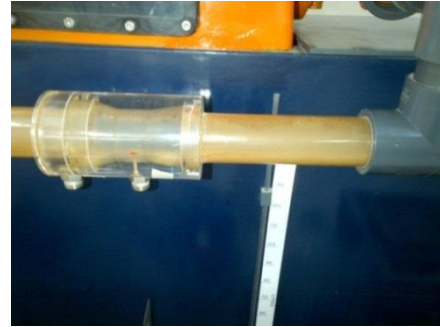
Fig. 15. Vista frontal de la tubería durante la inspección inicial. [Fotografía de autores]
