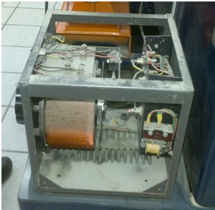
Fig. 18. Vista interior del variador de frecuencia al momento de la inspección inicial. [Fotografía de autores]
