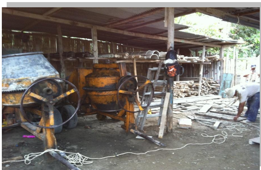
Figura N° 23: Encofrados y Hormigones – Huaquillas Emprendedor: Santos Farfán Farfán
