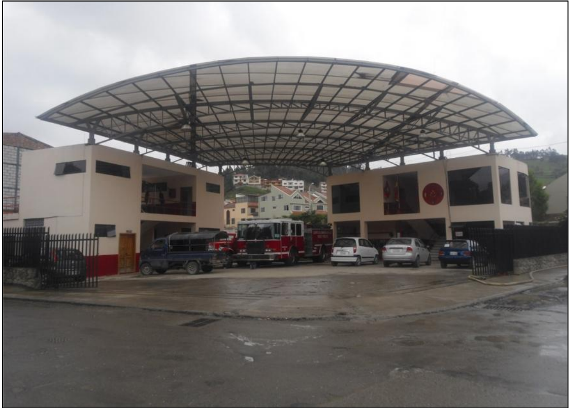
Figura 79. Estación de Bomberos Loja – Norte
