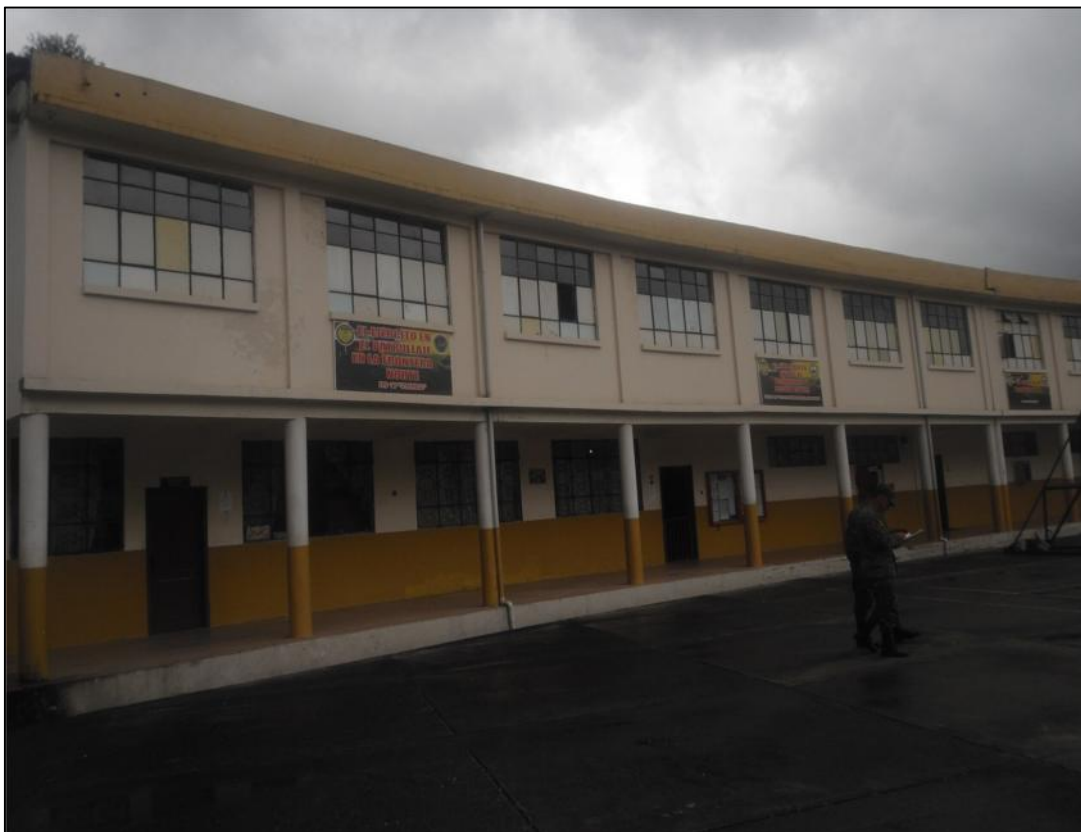
Figura 76. Brigada de Infantería – Edificio Dormitorios 1
