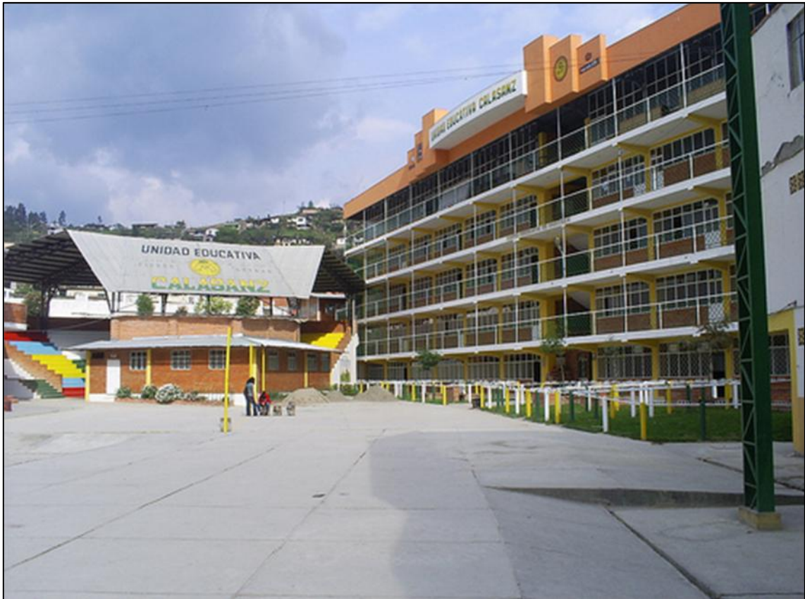
Figura 73. Unidad Educativa “Calazans” – Edificio Aulas. Fuente: El autor
