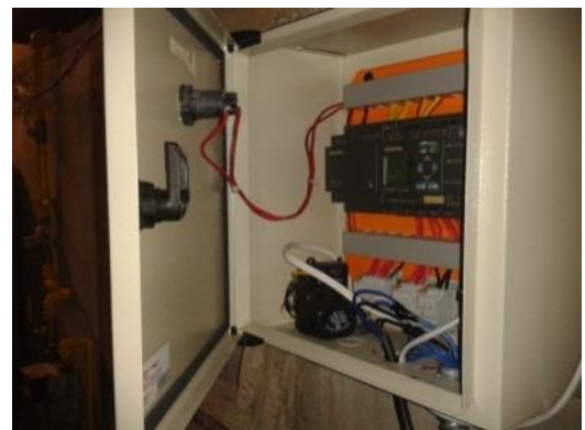
Fig. 4. Tablero de control del sistema de provisión de ACS a la CU UTPL. Fotografía de los autores.
