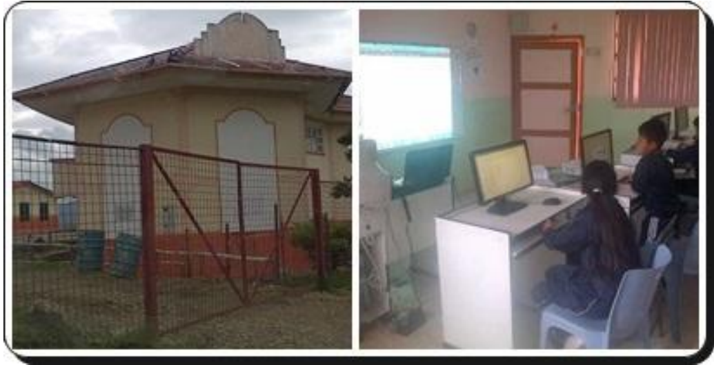
Figura 1. 5. Vista frontal y Centro de Cómputo UEM Capulí Loma
