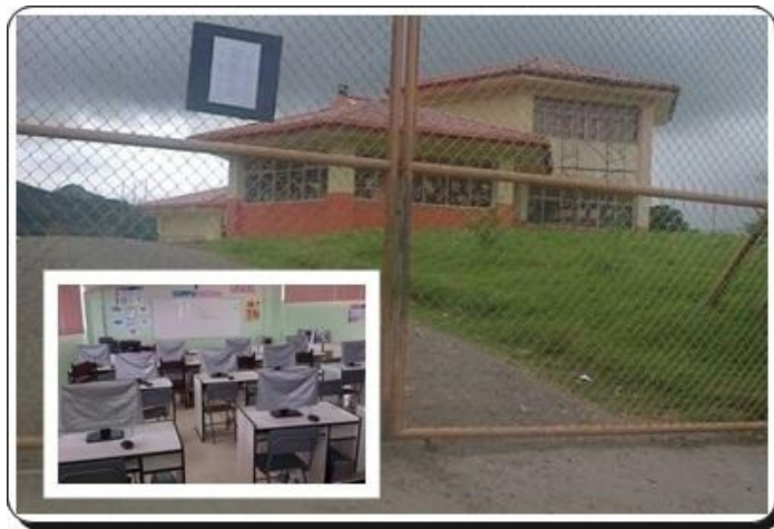
Figura 1. 3. Vista frontal y Centro de Cómputo UEM Tierras Coloradas.
