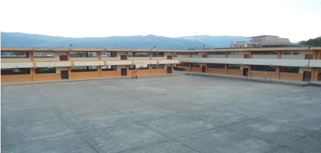
Fuente: Imágenes de la Escuela General Rumiñahui Autor: Geovanny Aguirre
