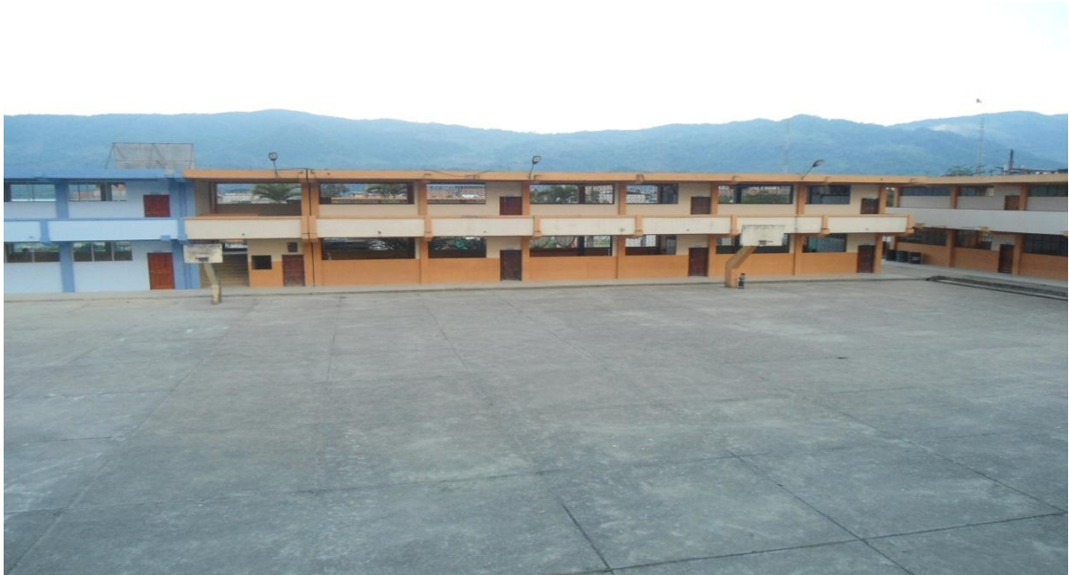
Fuente: Imágenes de la Escuela General Rumiñahui Autor: Geovanny Aguirre
