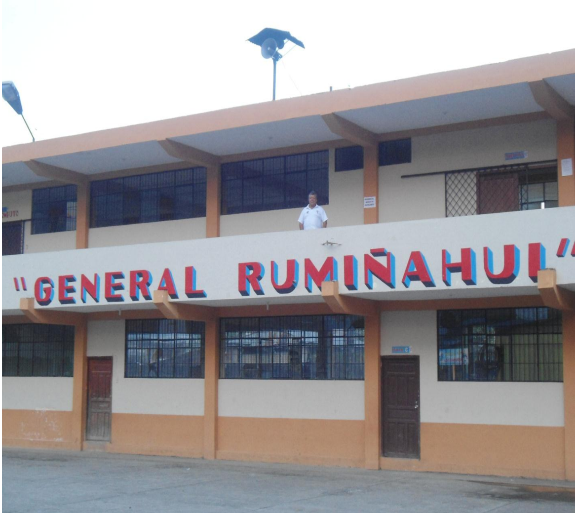
Fuente: Imágenes de la Escuela General Rumiñahui Autor: Geovanny Aguirre
