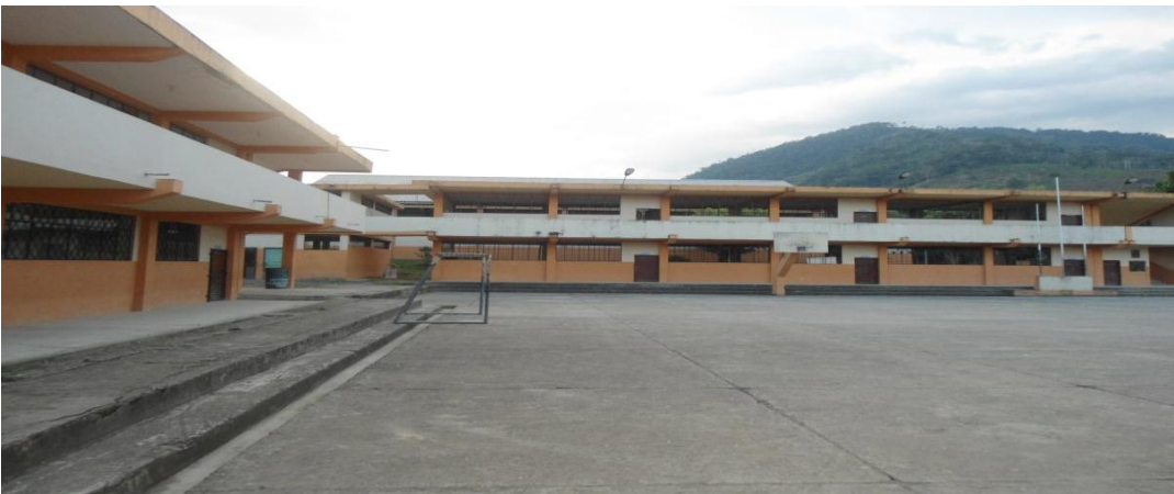
Fuente: Imágenes de la Escuela General Rumiñahui Autor: Geovanny Aguirre
