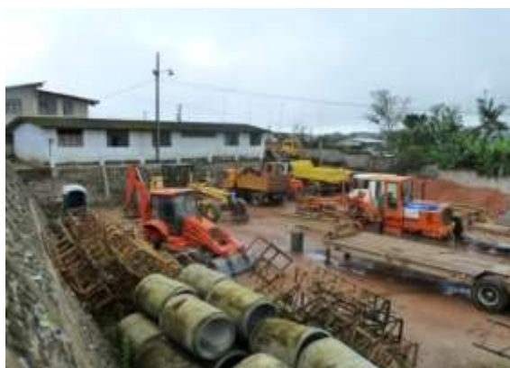
Foto 15.- Patio de máquinas de equipo pesado
