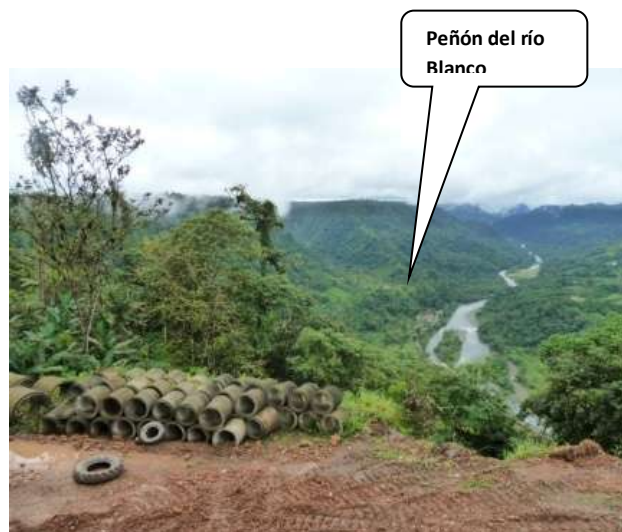
Foto 6.- Parte posterior del campamento vial del GAD-PP que es parte del peñón del río Blanco.
