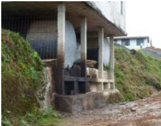
Foto 17.- Tanque de diesel abandonado contaminando el suelo por el derrame
