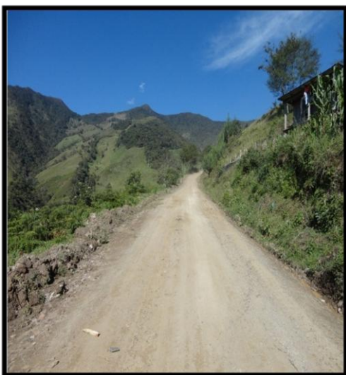
Imagen N°1. Estado de la vía urbana
