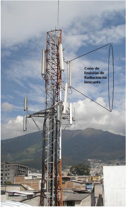
Ejemplo de cono de emisión de radiación no ionizante proveniente de una antena celular
