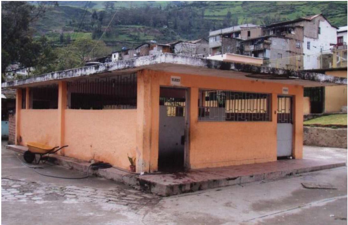
Sanitarios de la institución
