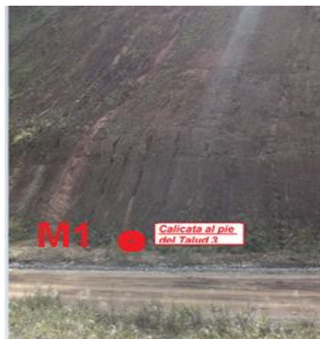
Figura 14: Calicata en Talud 3. Fuente: El autor
