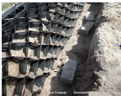
Figura 23: Instalación de geocelda en la zanja de anclaje
