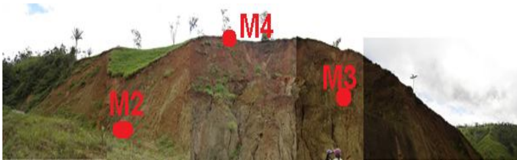
Figura 15: Calicatas en Talud 2 Fuente: El autor
