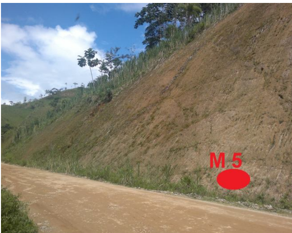
Figura 13: Calicata en Talud 1. Fuente: El autor
