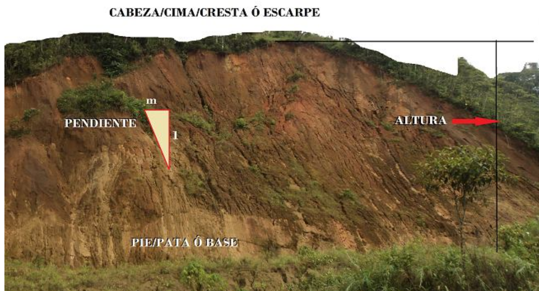
Figura 1: Partes de un talud Fuente: El autor
