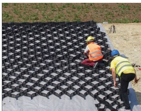
Figura 24: Disposición de geosintéticos
