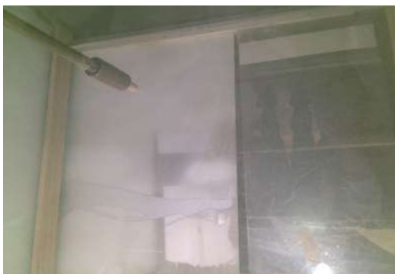
Figura 12: Detalle de la manguera expulsando arena.
