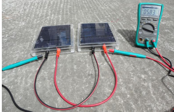
Figura 6.8. Medición de corriente en un arreglo de 2 paneles en serie.
