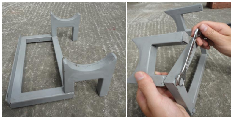
Figura 6.21. Instalación del soporte del sistema termosolar. Fuente: fotografías de los autores
