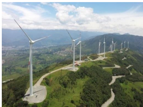
Figura 3.3. Parque eólico Villonaco.
