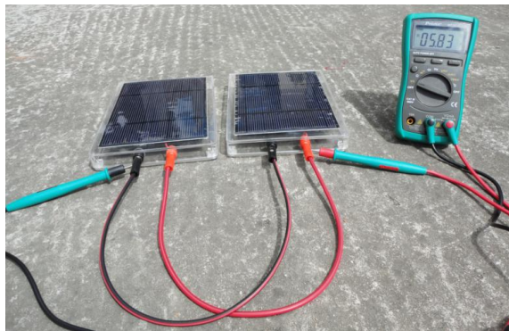
Figura 6.11. Medición del voltaje en un arreglo de 2 paneles solares en paralelo. Fuente: fotografía de los autores
