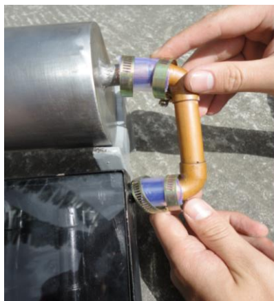
Figura 6.24. Armado de la tubería entre el colector y el tanque de almacenamiento.
