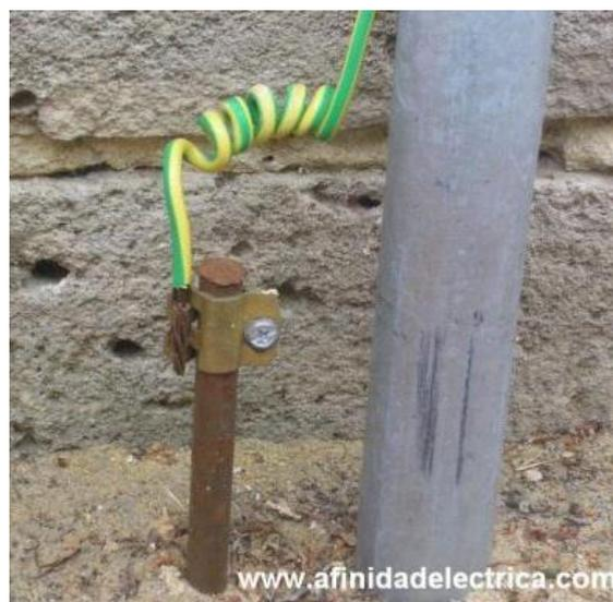
**Figura 1.9.** Conductores de protección.
