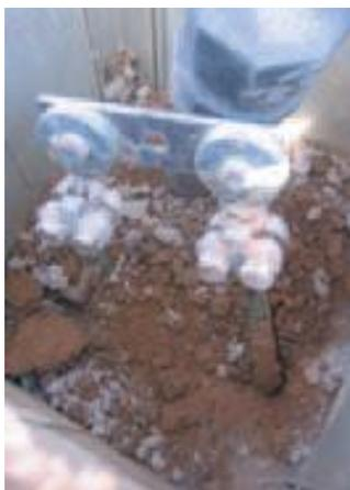
**Figura 1.7.** Conductores de tierra.
