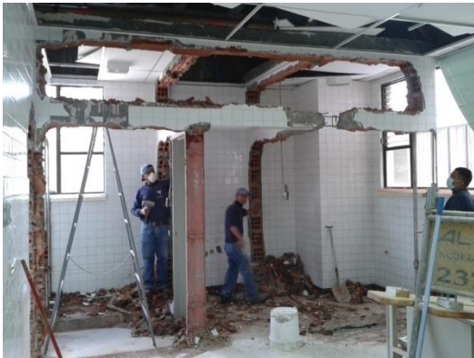
Fotografías 19-20: ampliación de puertas
