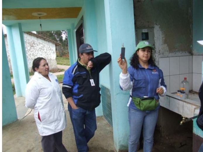
Fotografía 13: Plan de actividades de la comunidad: monitoreo y control de Ph y Cloro en la planta de Tratamiento.
