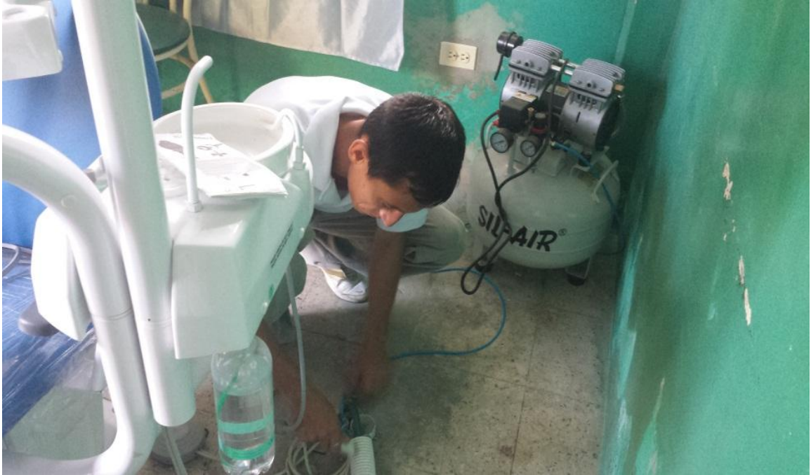
Personal enviado para la instalación de equipos.
