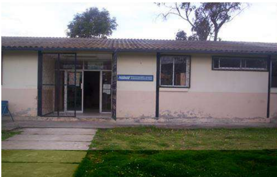
Fuente: Foto del Subcentro de Salud de Quisapincha
