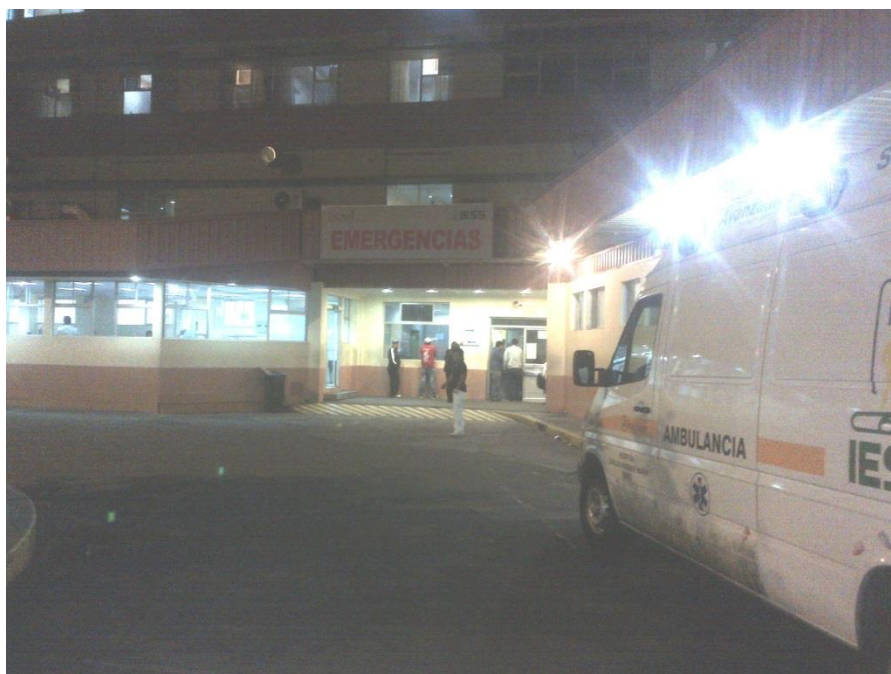
Foto 11. ENTRADA AL SERVICIO DE EMERGENCIA HCAM
