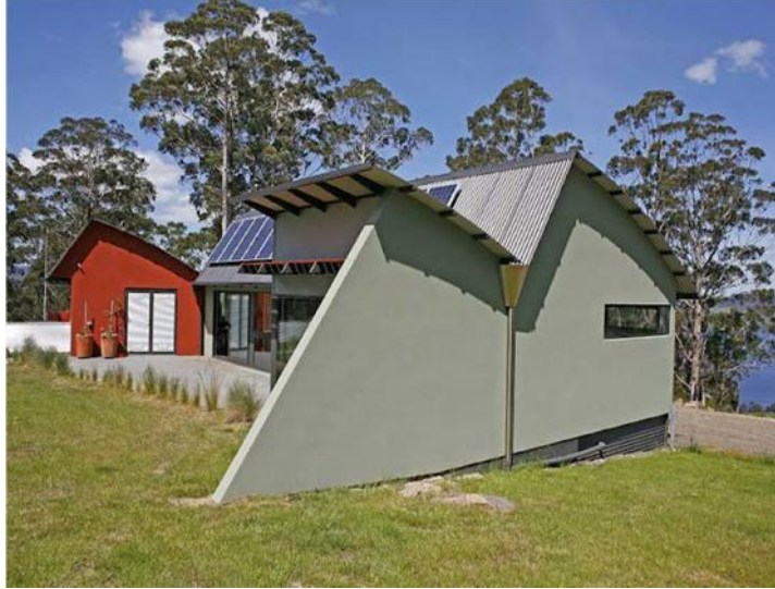
Figura 1.1. Vivienda de campo diseñada y construida para ser energéticamente sustentable.
