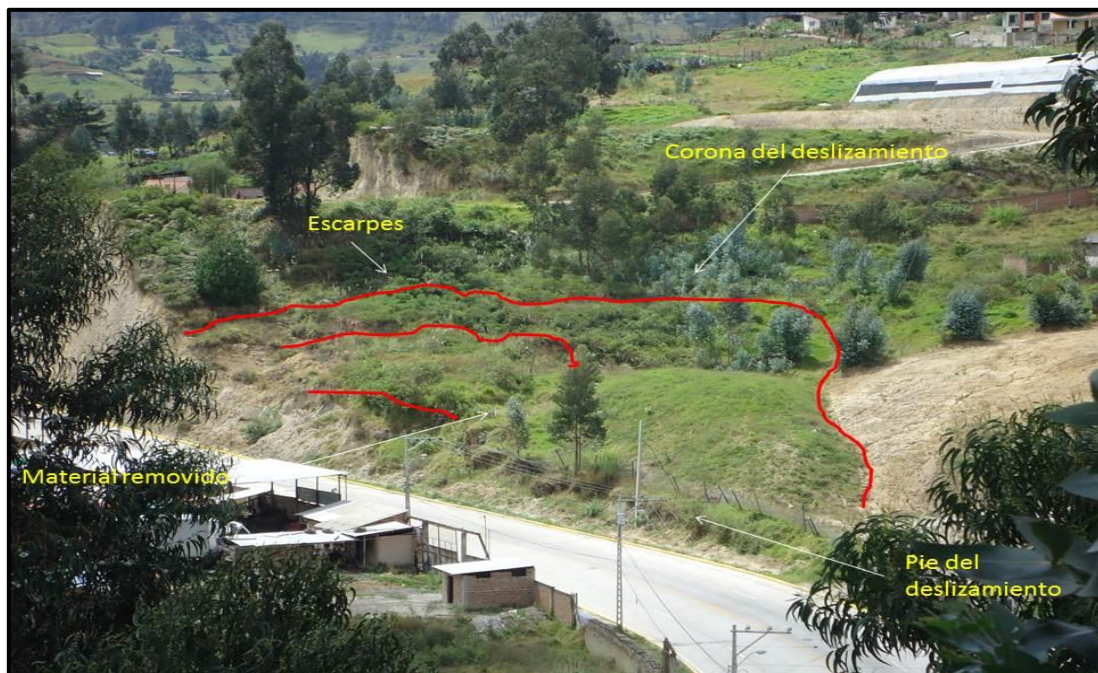
Foto 12.- Deslizamiento 2 junto a la Vía Loja – Zamora, cerca de la entrada de los Misioneros Identés.
