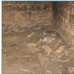
Detalle de cimentación de piedra
