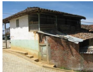
Vista Posterior de la vivienda (acceso)
