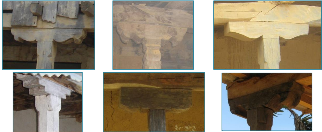
Diferentes tipos de capitel de pilares en portales Fuente: Autora/ Año: 2007 - 2008
