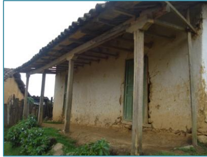
Vivienda de adobe con pilares de madera Fuente: Autora Año: 2008
