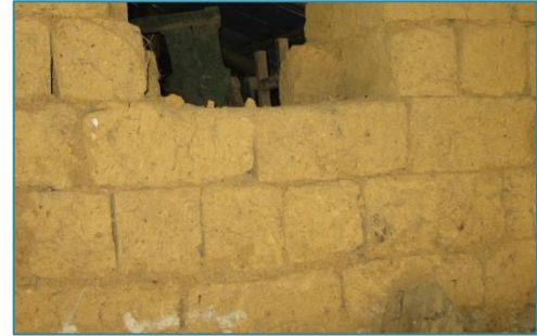
Disposición de bloques en doble hilera de adobe
