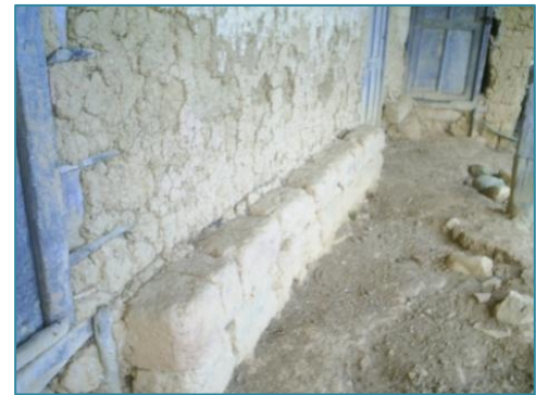
Vista de un banco adosado al muro (poyo de adobe) Fuente: Autora Año: 2008
