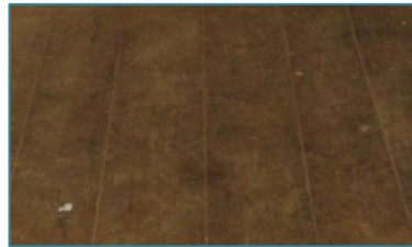
Piso del convento Fuente: Autora Año: 2008
