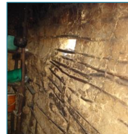
Detalle de chacla aplicada en Mampostería de tierra Fuente: Autora Año: 2008
