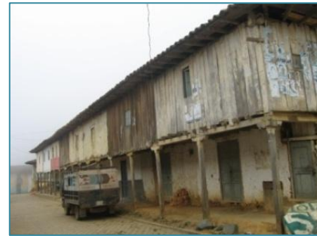
Vista del primer cuartel militar en Guachanamá. Tipología en construcción con madera Fuente: Autora; Año: 2008
