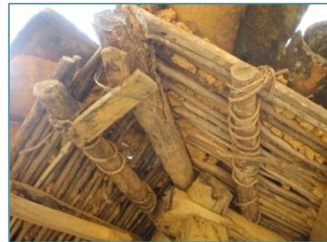
Detalle de cubierta. Muestra el entramado de chacla cubierto con barro para proteger de la intemperie
