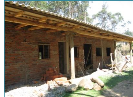
Vivienda de hormigón con mampostería de ladrillo. Portalería con pilares de madera. Fuente: Autora Año: 2008
