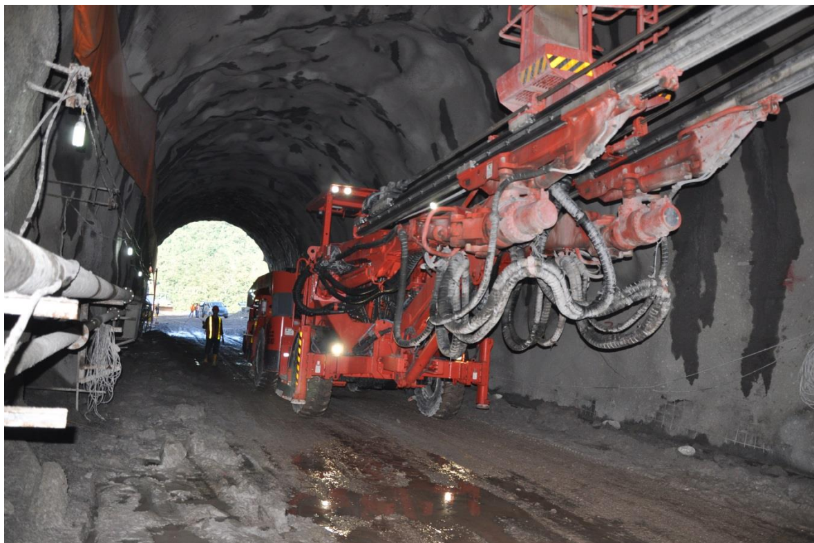
ANEXO 9 Túnel de Conducción (Ventana 1)
