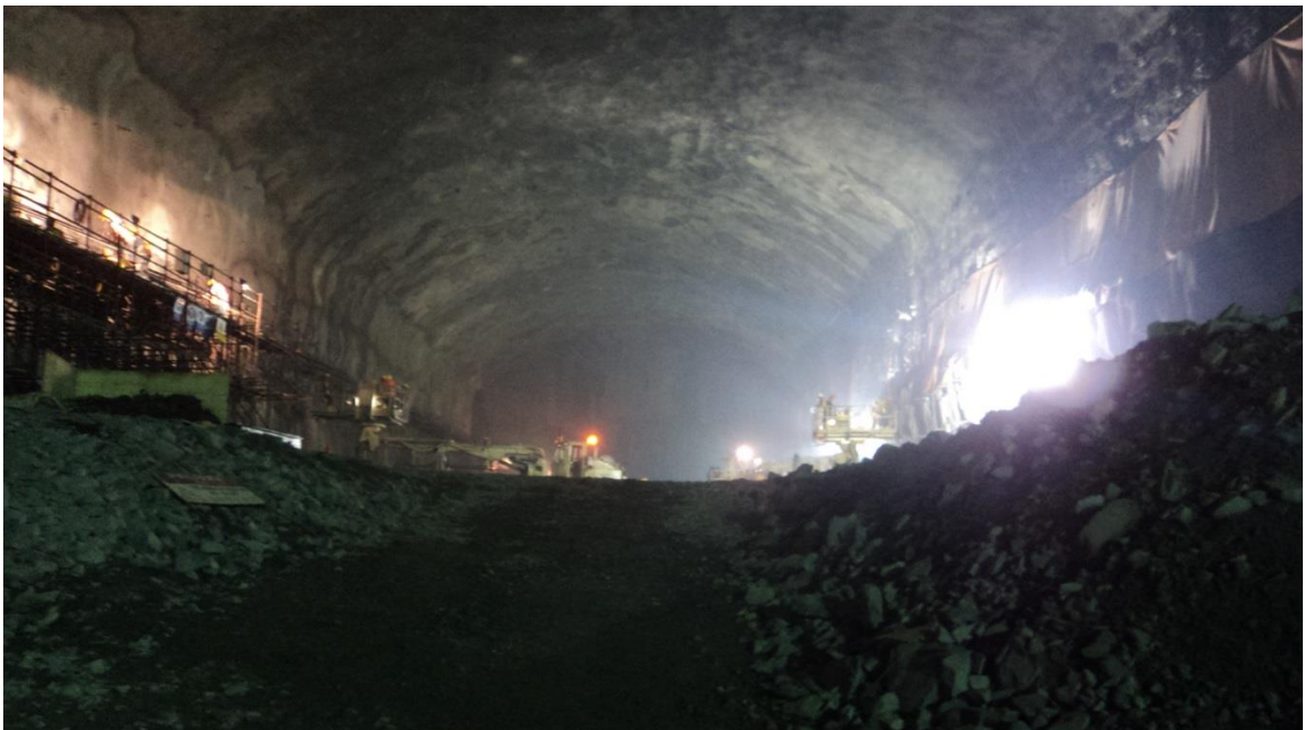
ANEXO 8 Túnel de Casa de Maquinas
