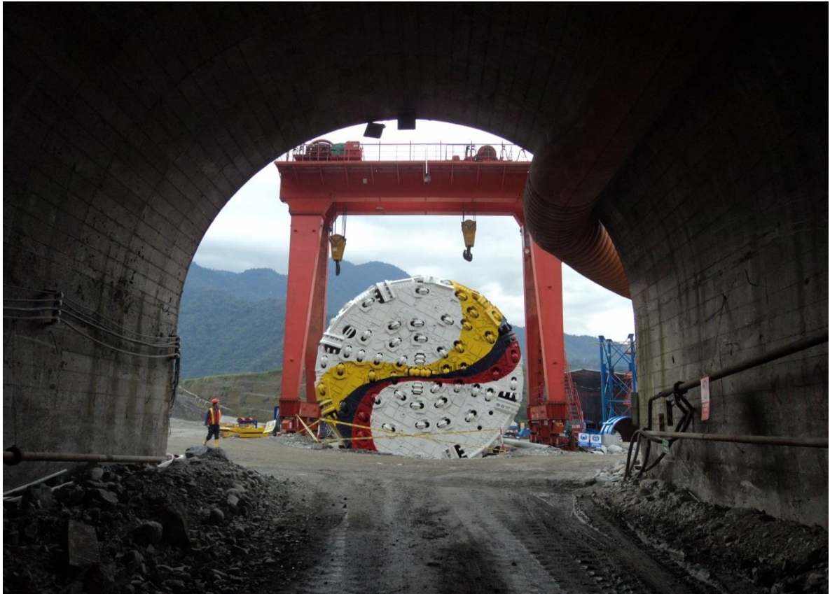
ANEXO 7 Túnel de Conducción (Ventana Dos)
