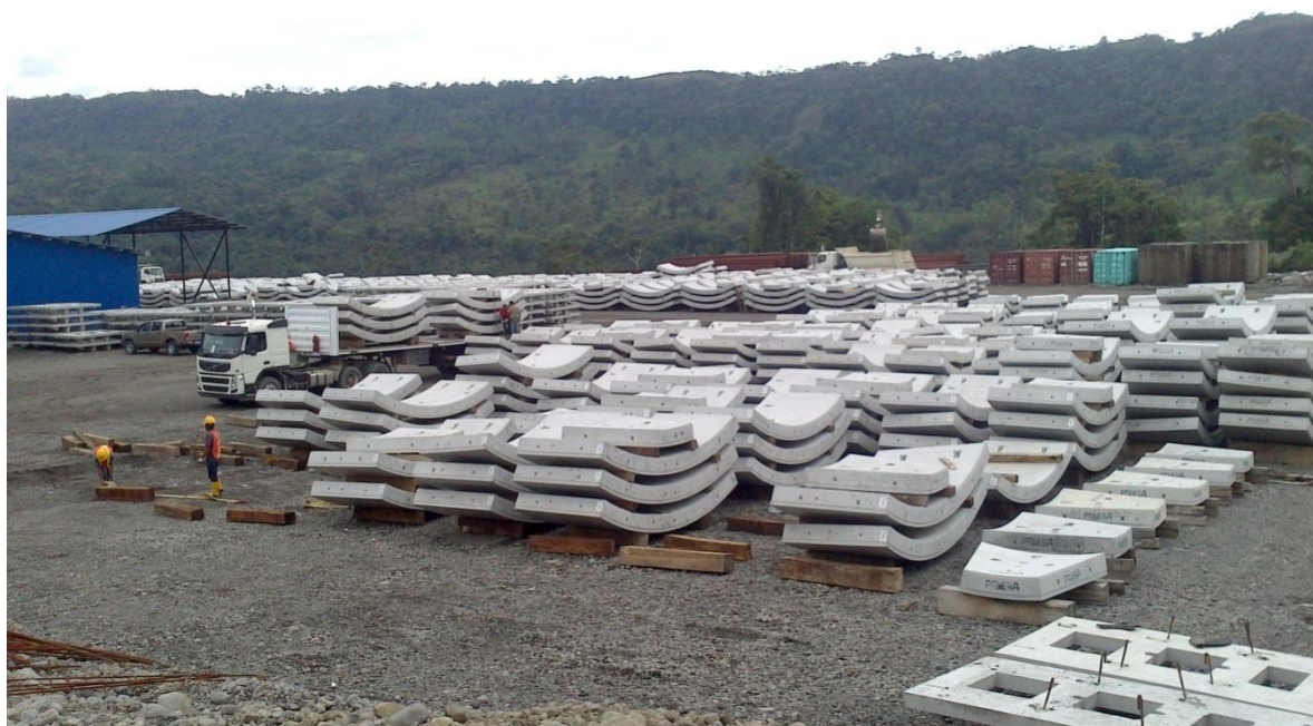
ANEXO 10 Fábrica de dovelas
