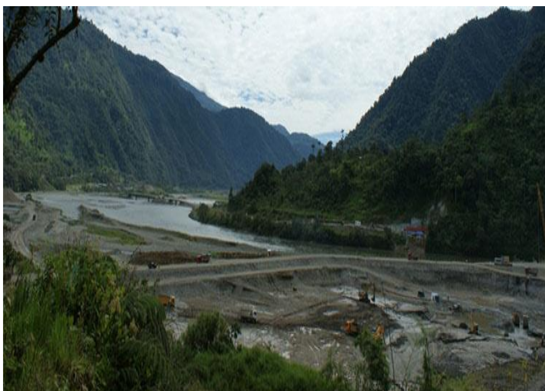
ANEXO 14 Obra de Captación Salado – Ventana 1
