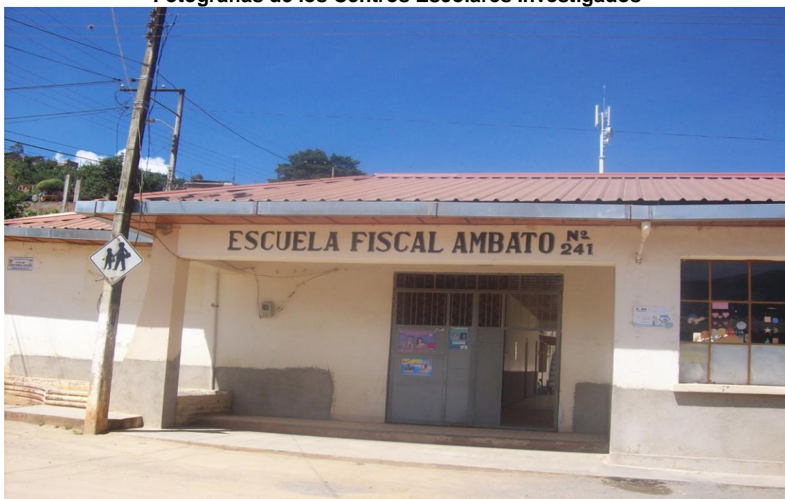
Fotografía 1: Vista frontal del edificio donde funciona la Escuela Fiscal Mixta Ambato de Cariamanga
