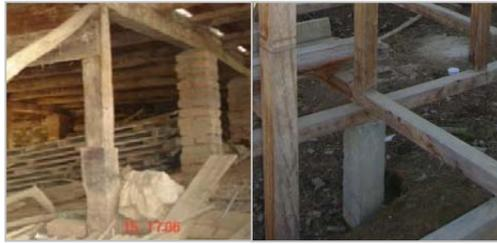
Figura 59. Estructura del piso elevado
