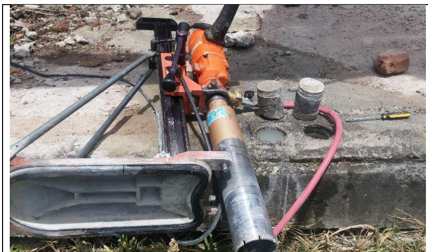
Figura Anexo 5. Cilindros de concreto sacados mediante broca diamante.
