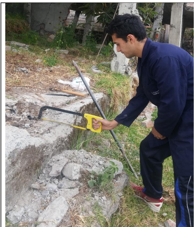
Figura Anexo 16. Extracción del acero de refuerzo del elemento estructural “VC”.
