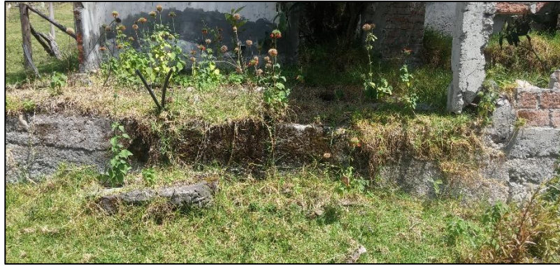
Figura 16. Elemento estructural "VC"
