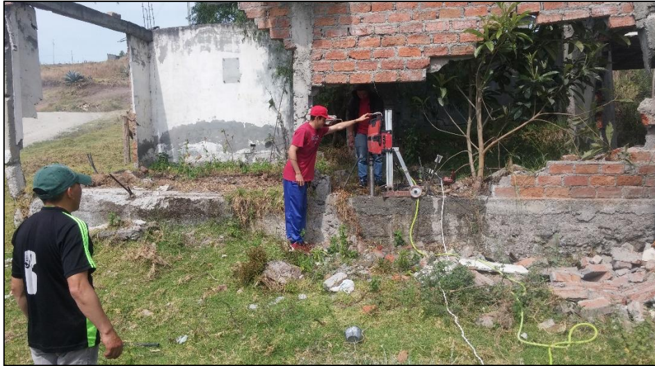
Figura 23. Extracción de núcleos de hormigón.
