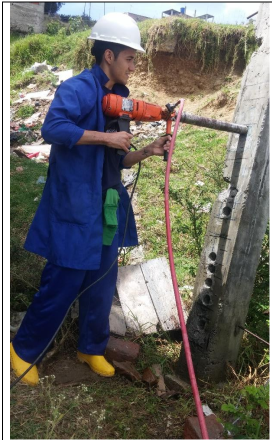
Figura Anexo 4. Extracción de núcleos de hormigón.
