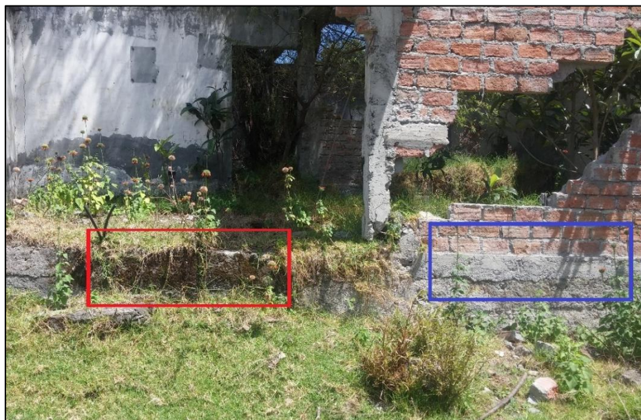
Figura 40. Cadena de desplante del elemento estructural "VC".
