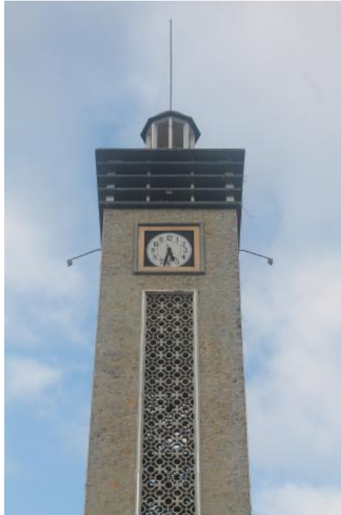
Figura 48 fotografía de la parte superior de la torre de San Sebastián. Fuente: Adriana Ontaneda. Elaboración: El autor
