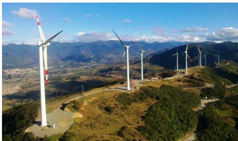
Figura 3 Parque eólico Villonaco
