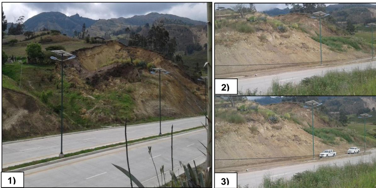
Figura 29. Secuencia del daño ocasionado por el deslizamiento al funcionamiento de la infraestructura lineal.
